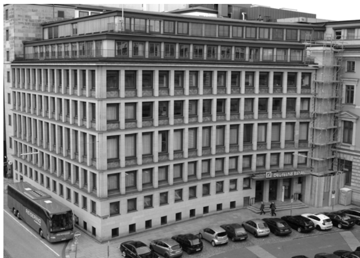
Deutsche Bank am Adolphsplatz, vom Dach der Börse aus gesehen. Hier stand Zingg's Hotel
